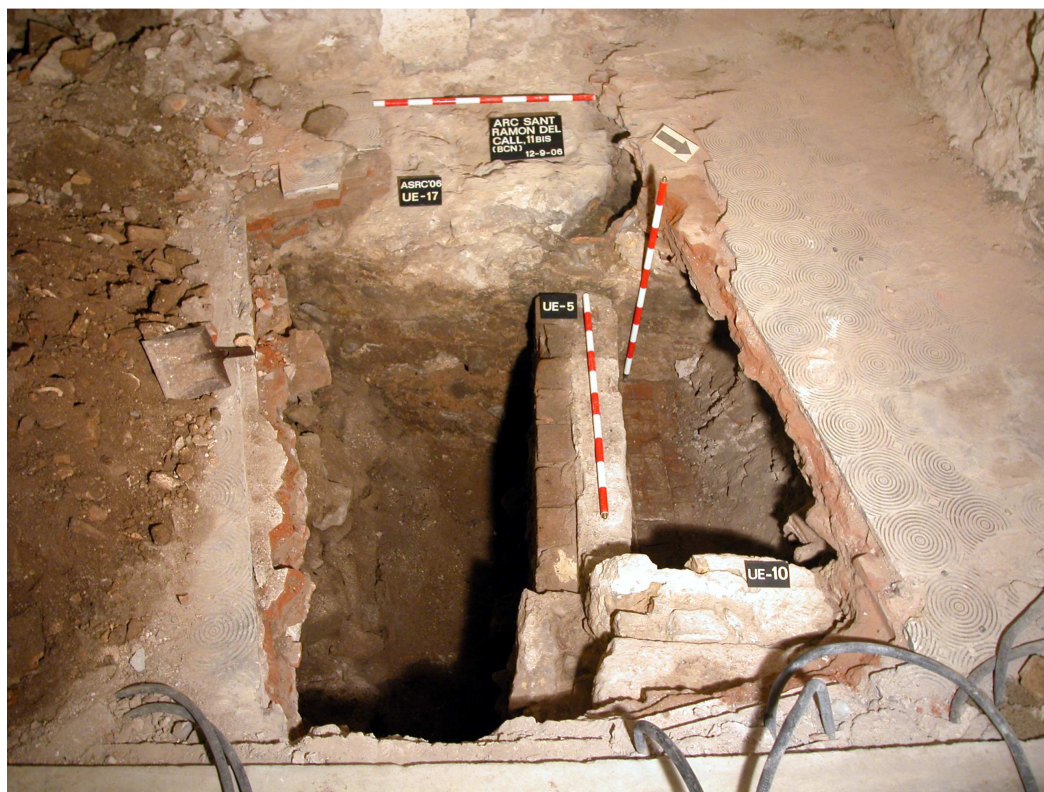
ARC DE SANT RAMON DEL CALL, 11 (Barcelona).- Vista general de l'indret on es va efectuar la cala de sondeig arqueològic. Es pot observar l'arqueta d'època moderna, localitzada al costat dret de la cala.
